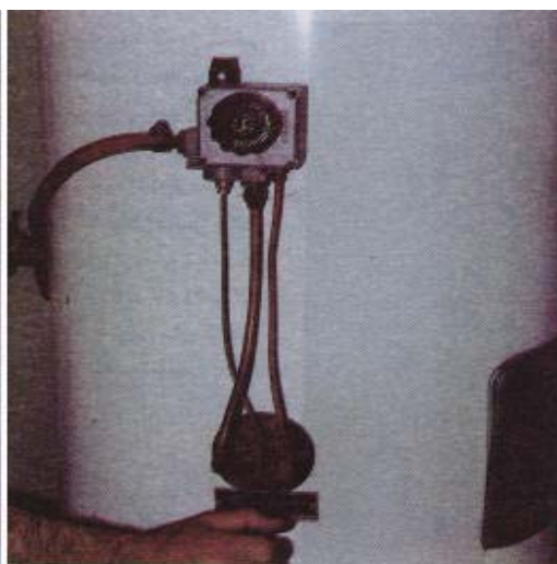
۲- توسط پیچ گوشنی دوسو یا چهارسو پیچهای اتصال اجاق را باز کنید.
